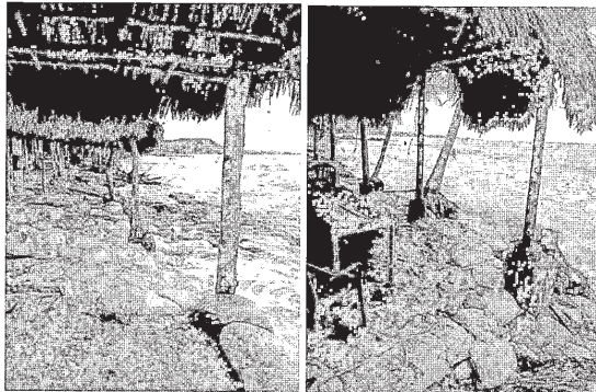
(Registro Fotográfico- Acciones de mitigación Erosión Costera Corregimiento de Santa Verónica 9 )
