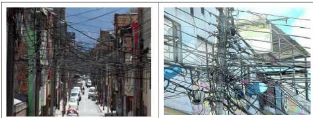
Fotografías, enrollo de cables (El Tiempo, 2019).
